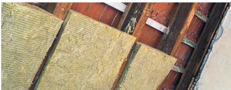
Wärmedämmung von innen: Zwischensparrendämmung
