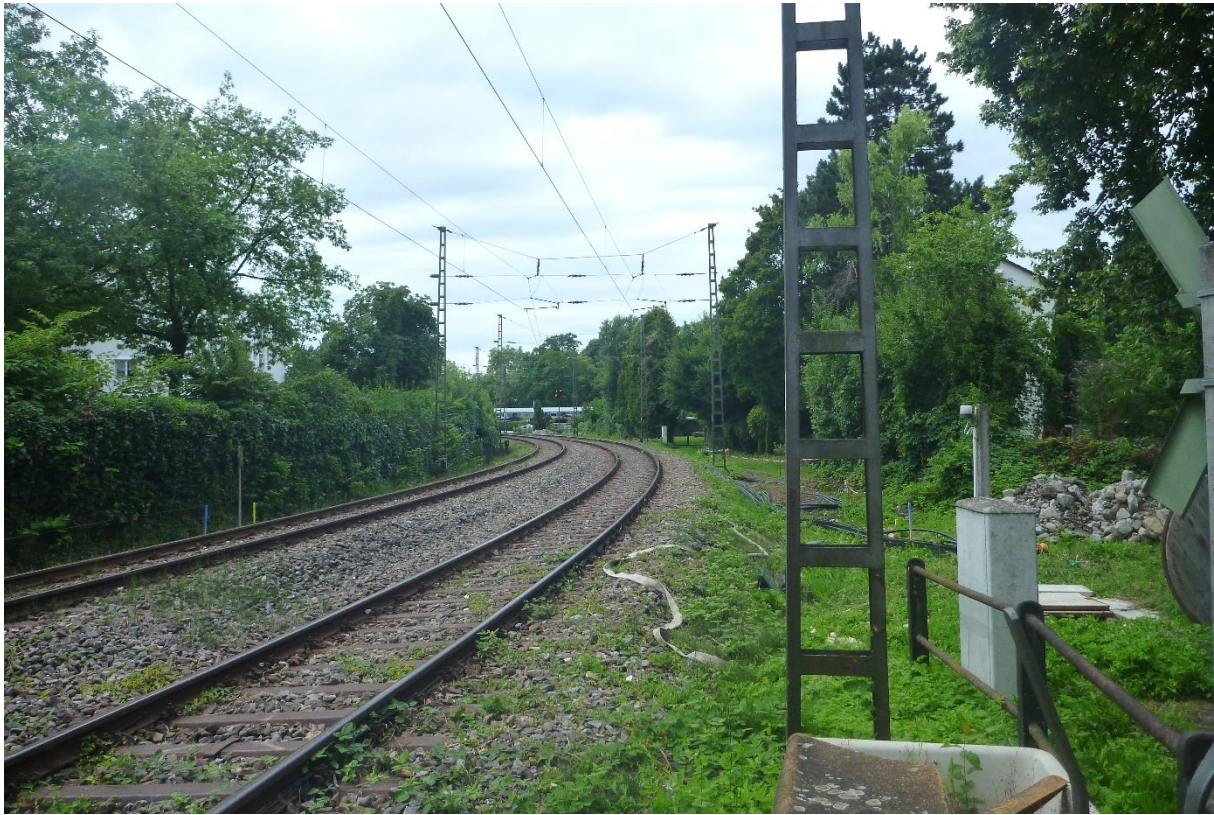
Abbildung 7: Gleisbereich westlich des BÜs mit angrenzenden Ruderalflächen sowie Gehölzstrukturen und Einzelbäumen; Blick Richtung Westen (Foto: AFRY Deutschland GmbH, 2019)
