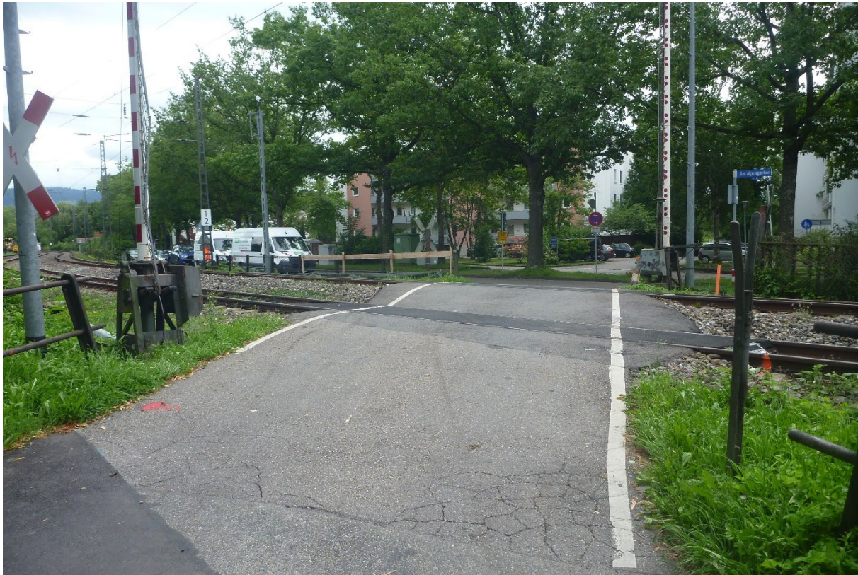
Abbildung 2 Abbildung 6: Blick auf den BÜ Hasenweidweg Ost Blick Richtung Süden (Foto: AFRY Deutschland GmbH, 2019)
