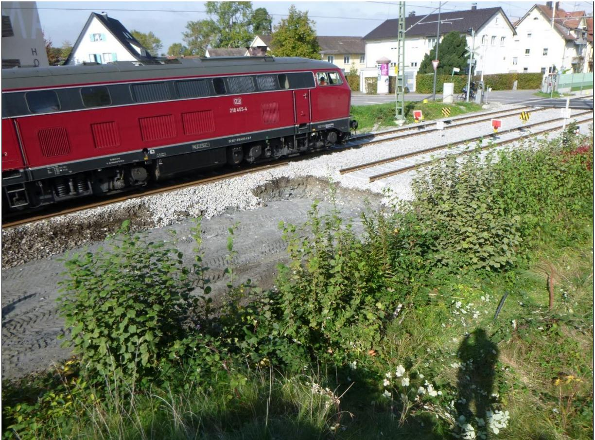
Abb. 1-3: Foto Geschiebemergel unterhalb Auffüllung und Gleisschotter Strecke 5362, Bereich BÜ Holdereggstraße, Foto während Ortsbesichtigung im Oktober 2023 während der Gleiserneuerung
