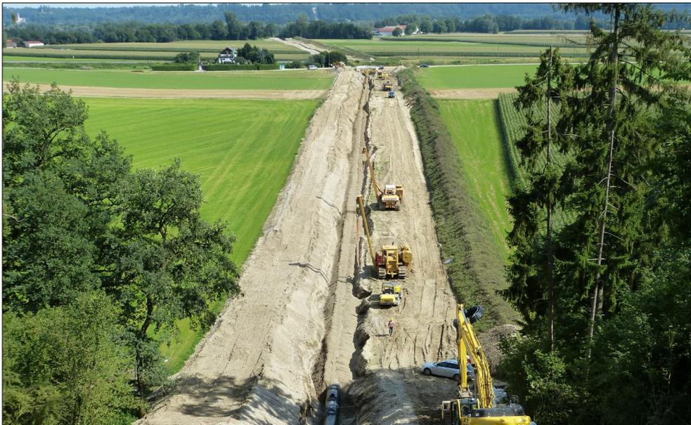
Abbildung 25 Übersicht Arbeitsstreifen und Verfüllen des Rohrgrabens
