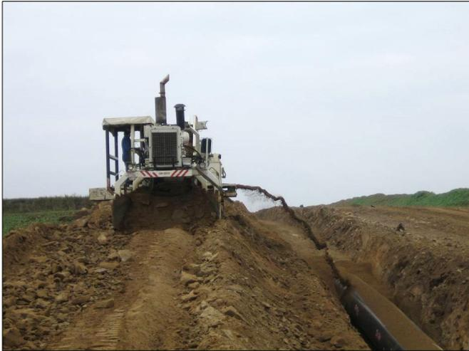
Abbildung 24 Verfüllen des Rohrgrabens
