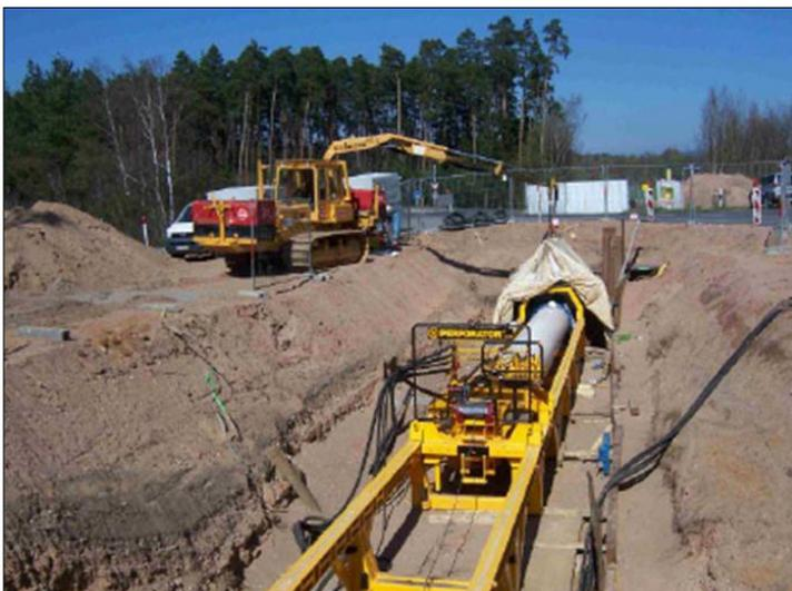
Abbildung 27 Horizontal-Bohr- / Pressverfahren
