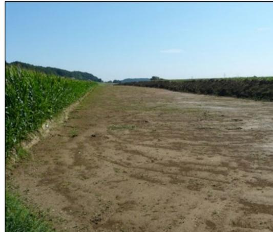
Abbildung 17 Trassenvorbereitung, Oberbodenabtrag
