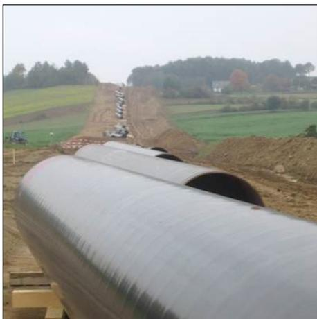
Abbildung 19 Ausgelegte Rohre auf dem Arbeitsstreifen
