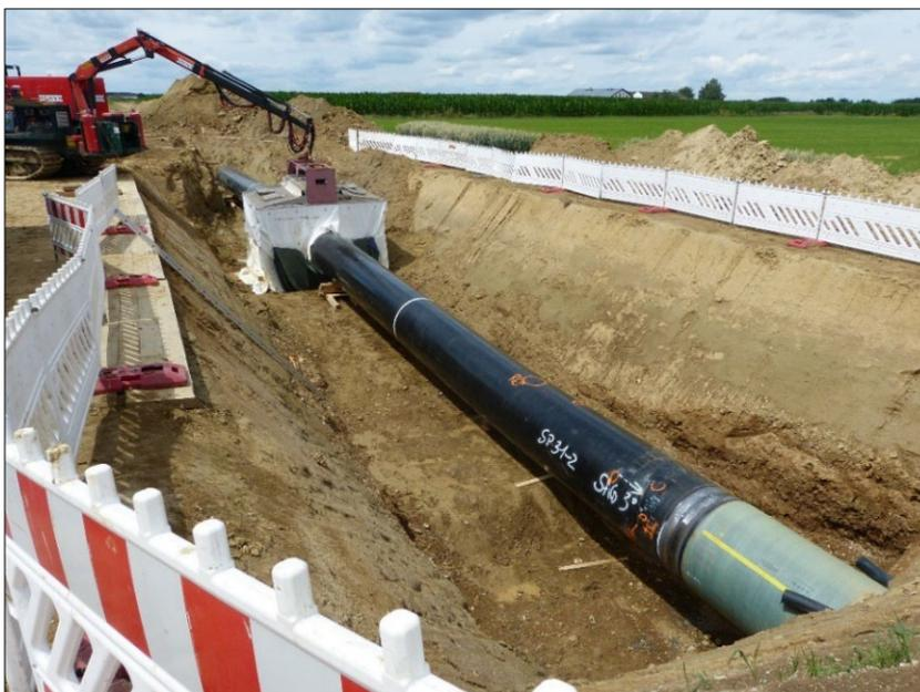
Abbildung 23 Verschweißen der Rohrstränge im Rohrgraben
