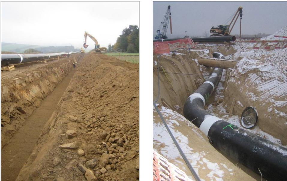
Abbildung 21 Erstellung des Rohrgrabens und Unterquerung von Fremdleitungen
