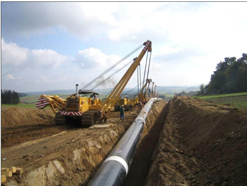
Abbildung 22 Absenken des Rohrstrangs mit Seitenbaumraupen
