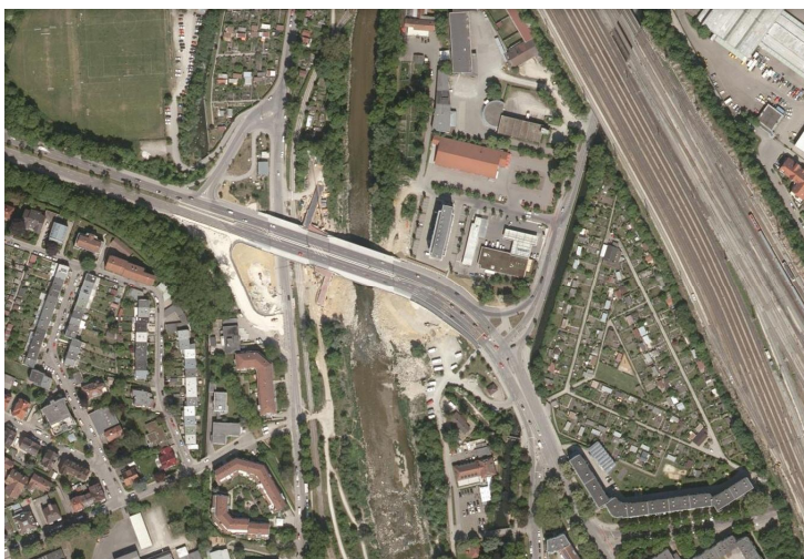
Abb. 5: Wertachbrücke an der Bgm. Ackermannstraße mit gerodeten Flächen
