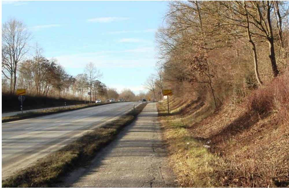
Foto 1 Gehölzbestand an der Ackermannstraße, Abschnitt A im Westen (westlich Kriegshaber Straße), Blickrichtung West, Winteraspekt, rechts nordseitige Böschung mit heckenartigem Laubholzbestand
