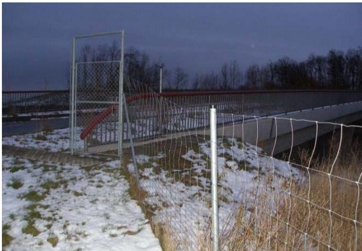
**Abbildung 13: Korrekter Anschluss eines Zauns/Sperreinrichtung am Eingang eines Querungsbauwerkes. Foto: aus LUGON et al. 2018.**
