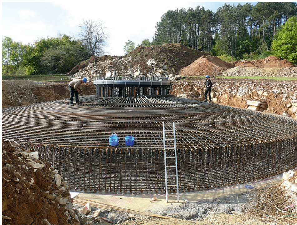
Errichtung des Fundaments
