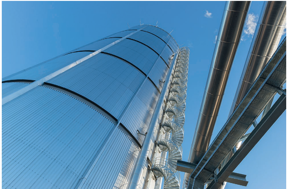
Der Wärmespeicher der N-ERGIE in Nürnberg-Sandreuth
