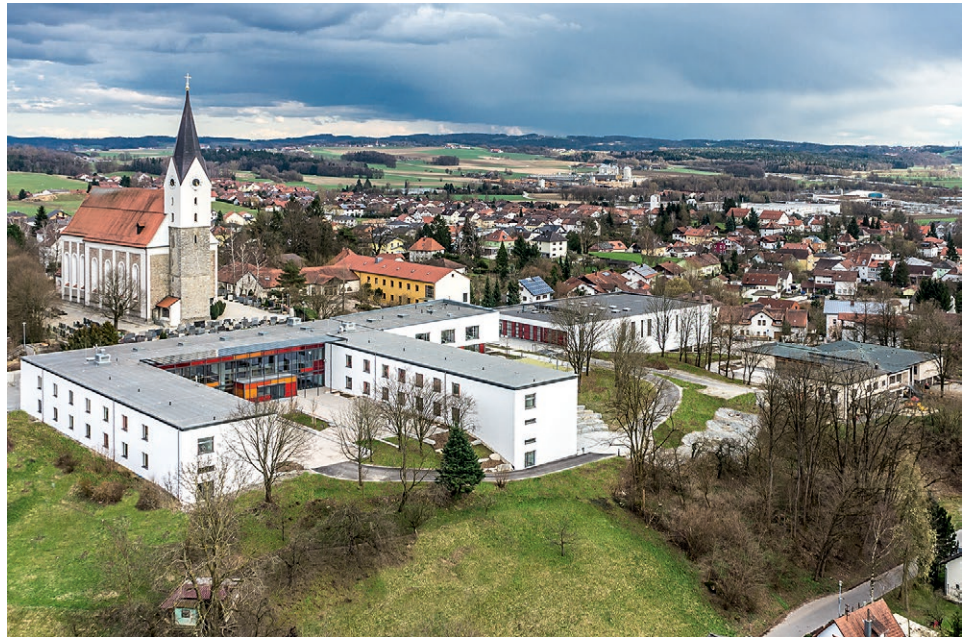
Schulgebäude der Mittelschule Hengersberg
