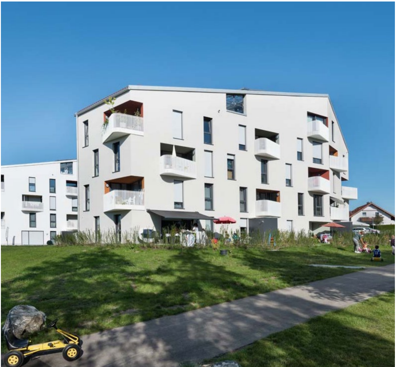
Belebte Freibereiche zwischen Privat und Halböffentlich
