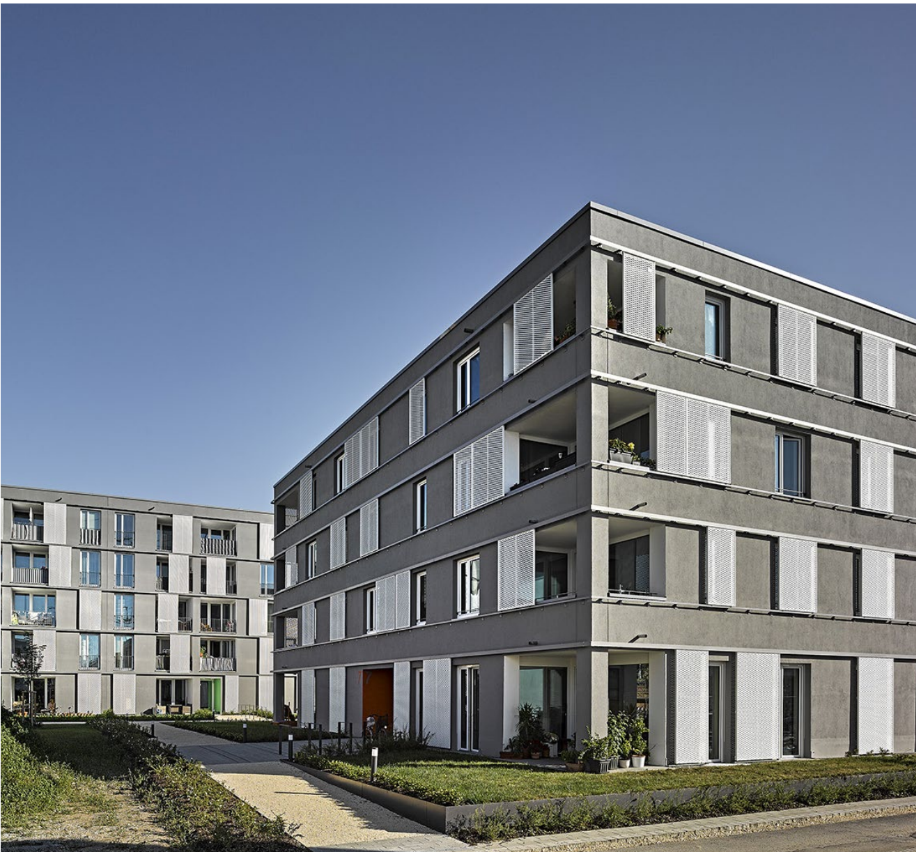
Ansicht Gartenseite mit Nachbargebäude der städtischen Wohnungsgesellschaft im Hintergrund
